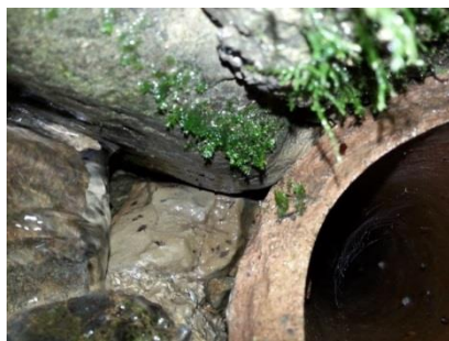
Фиг. 4 Керамичен водопровод - преливник
